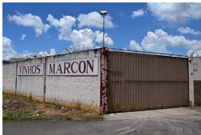
Imagem 05: adega Marcon – acesso restrito. Novembro de 2018. Bárbara Pereira Mañanares.
