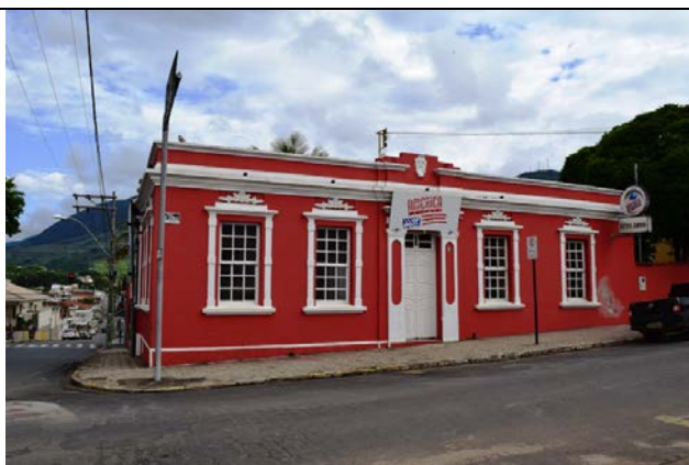
Imagem 04: Edificação à Rua Capitão Cirilo nº 11 (antiga casa dos Venturrelli). Novembro de 2018. Bárbara Pereira Mançanares.
