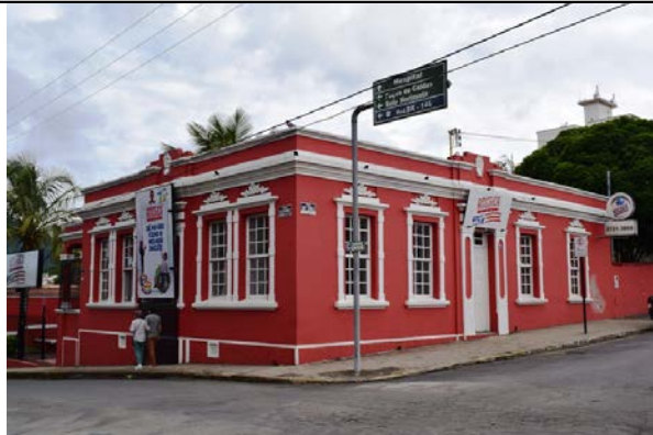
Imagem 01: Edificação à Rua Capitão Cirilo nº 11 (antiga casa dos Venturelli). Novembro de 2018.
