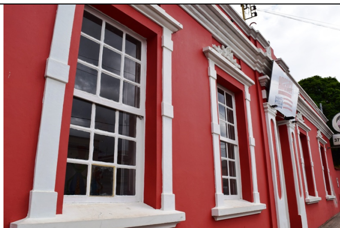
Imagem 07: Edificação à Rua Capitão Cirilo nº 11 (antiga casa dos Venturelli) – detalhes das janelas. Novembro de 2018. Bárbara Pereira Mançanares.
