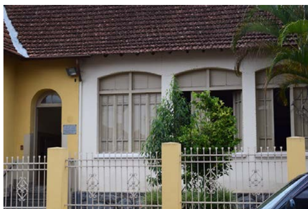
Imagem 03: Escola Municipal José Bonifácio – detalhe das janelas. Novembro de 2018. Bárbara Pereira Mançanares.
